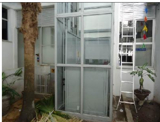
Foto 010 – Vista externa - piso inferior.
