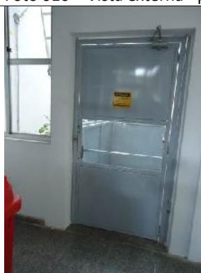
Foto 012 – Acesso de entrada do elevador - piso inferior.
