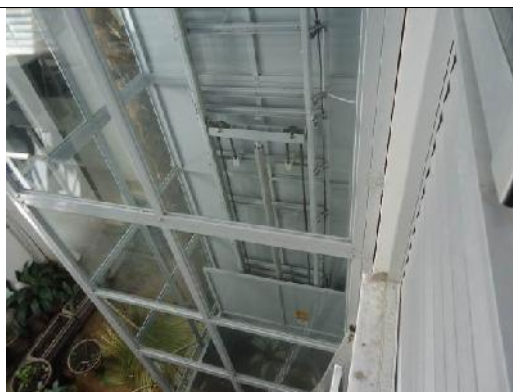
Foto 008 – Vista da estrutura do elevador.
