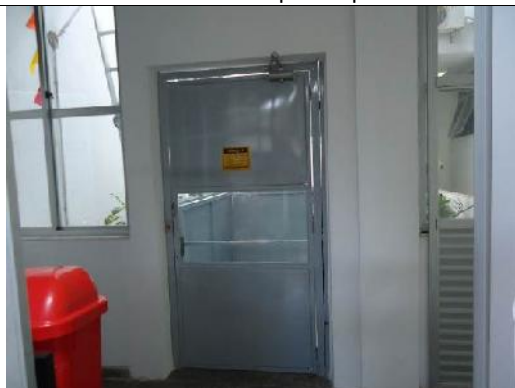
Foto 004 – Vista frontal - acesso ao elevador terreo.
